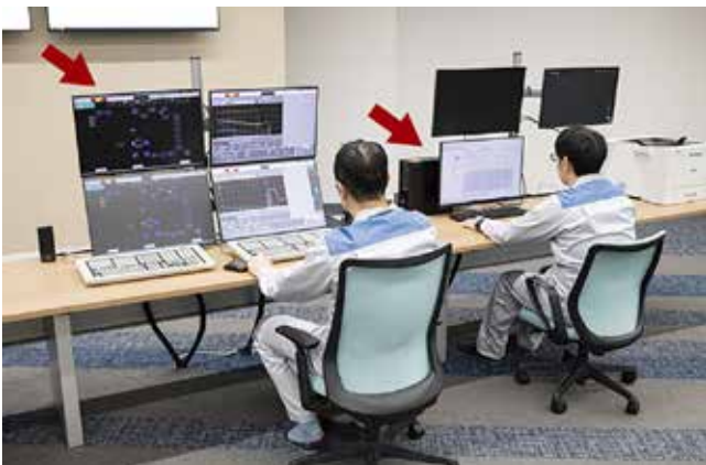
รูปที่ 3 จอด้านซ้ายของระบบควบคุม DCS จอด้านขวา Control Valve Maintenance Support System
